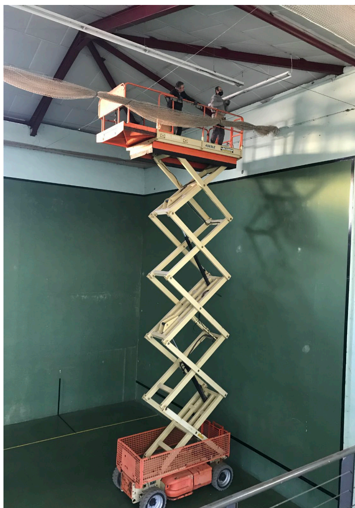
Mise en place de l'éclairage LED du mur à gauche
