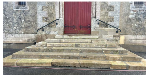
Escaliers de l'église avant/après.
